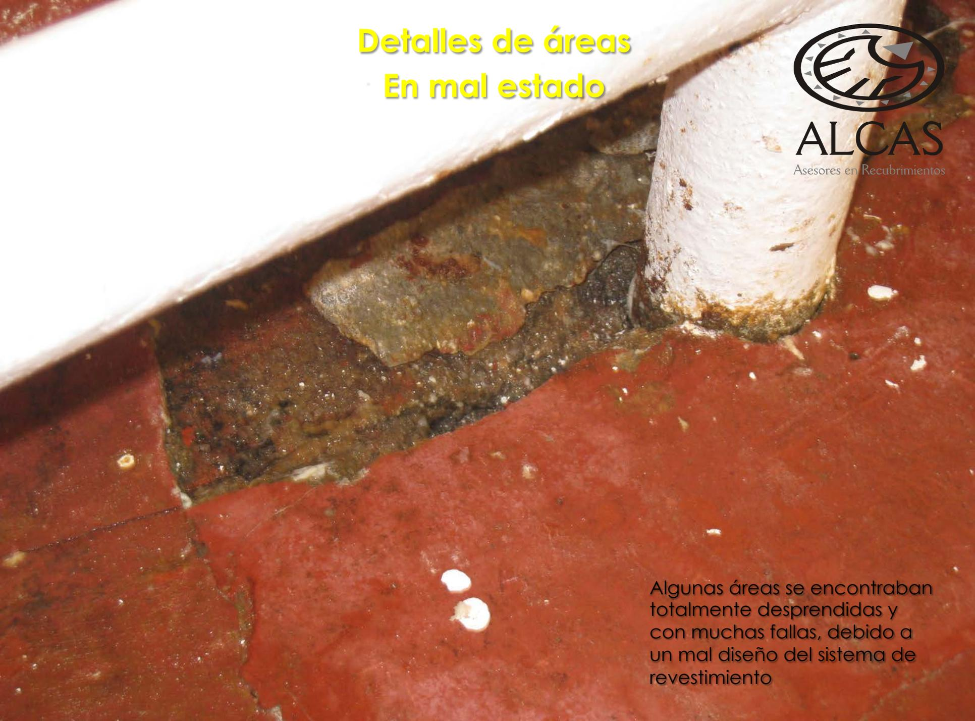
Algunas áreas se encontraban totalmente desprendidas y con muchas fallas, debido a un mal diseño del sistema de revestimiento
