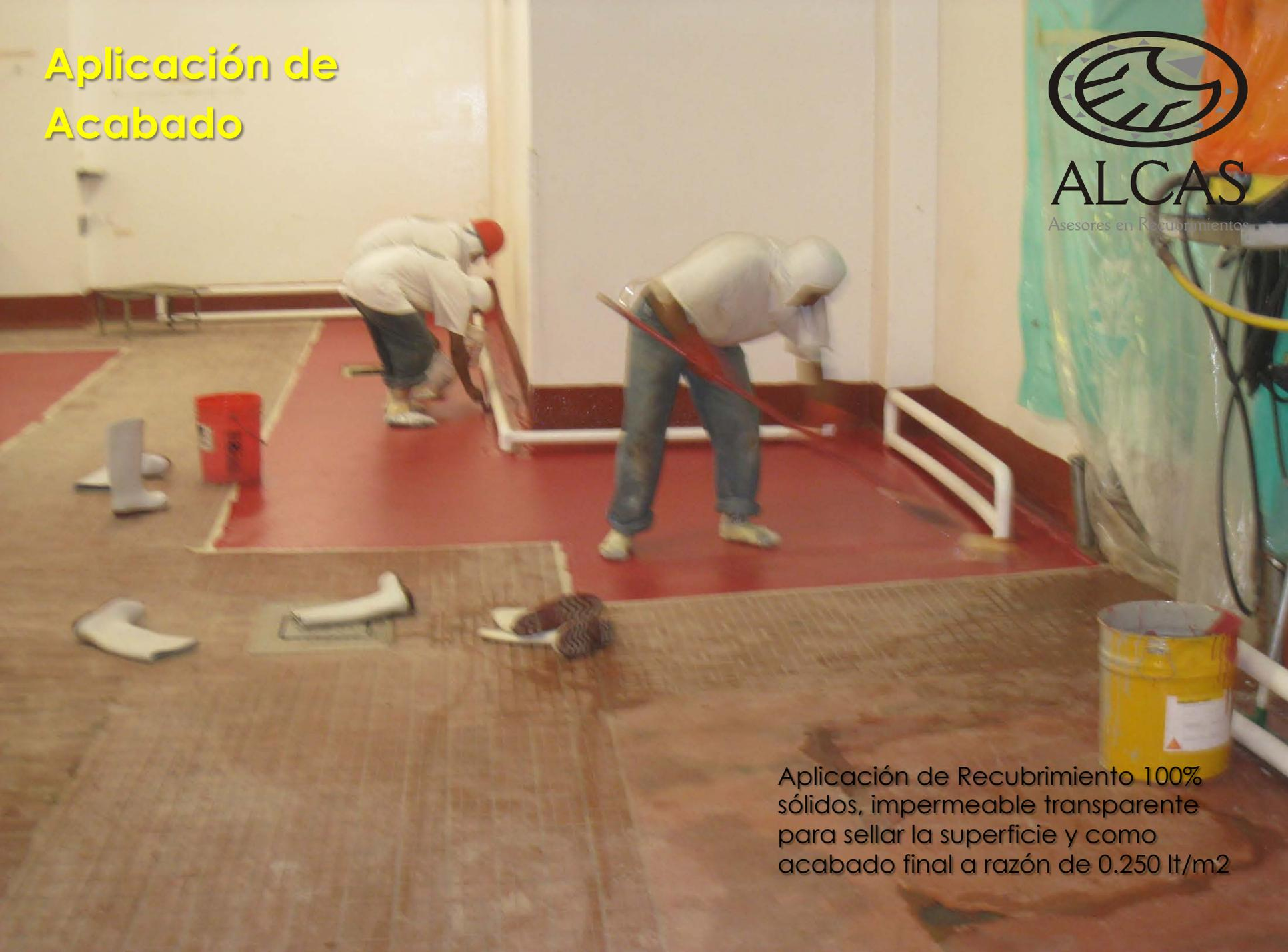
Aplicación de Recubrimiento 100% sólidos, impermeable transparente para sellar la superficie y como acabado final a razón de 0.250 lt/m<sup>2</sup>
