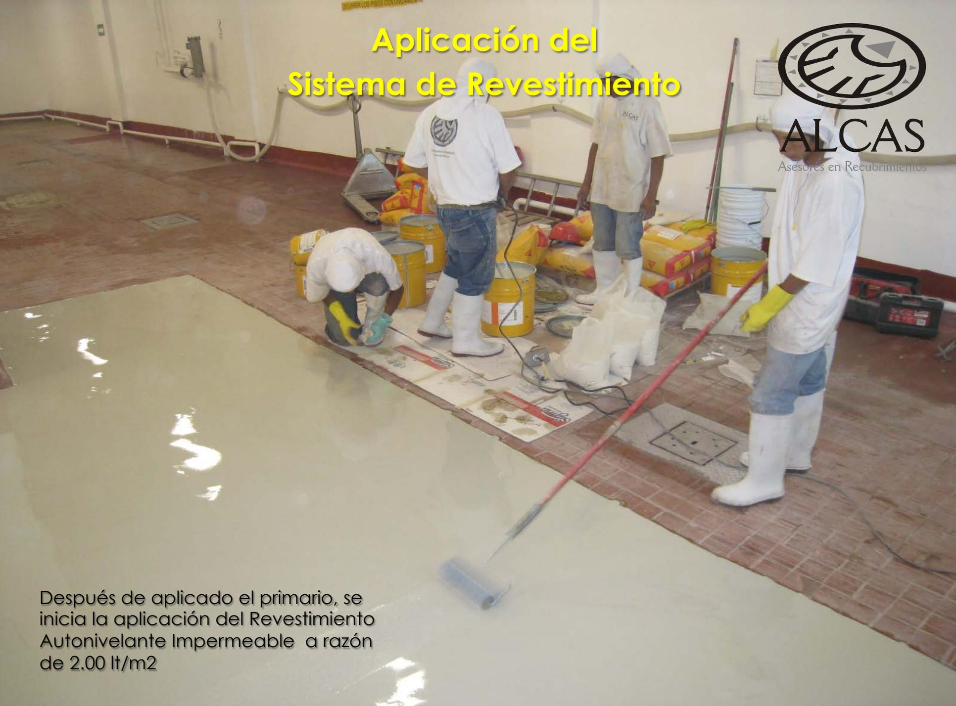
Después de aplicado el primario, se inicia la aplicación del Revestimiento Autonivelante Impermeable a razón de 2.00 lt/m<sup>2</sup>
