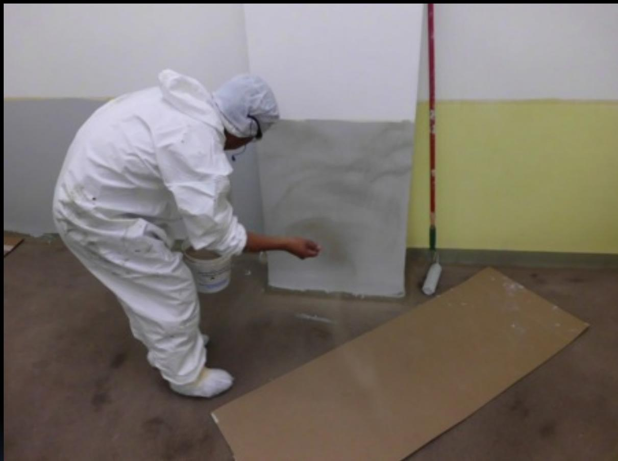
Aplicacion de Revestimiento en muros saturado de arena
