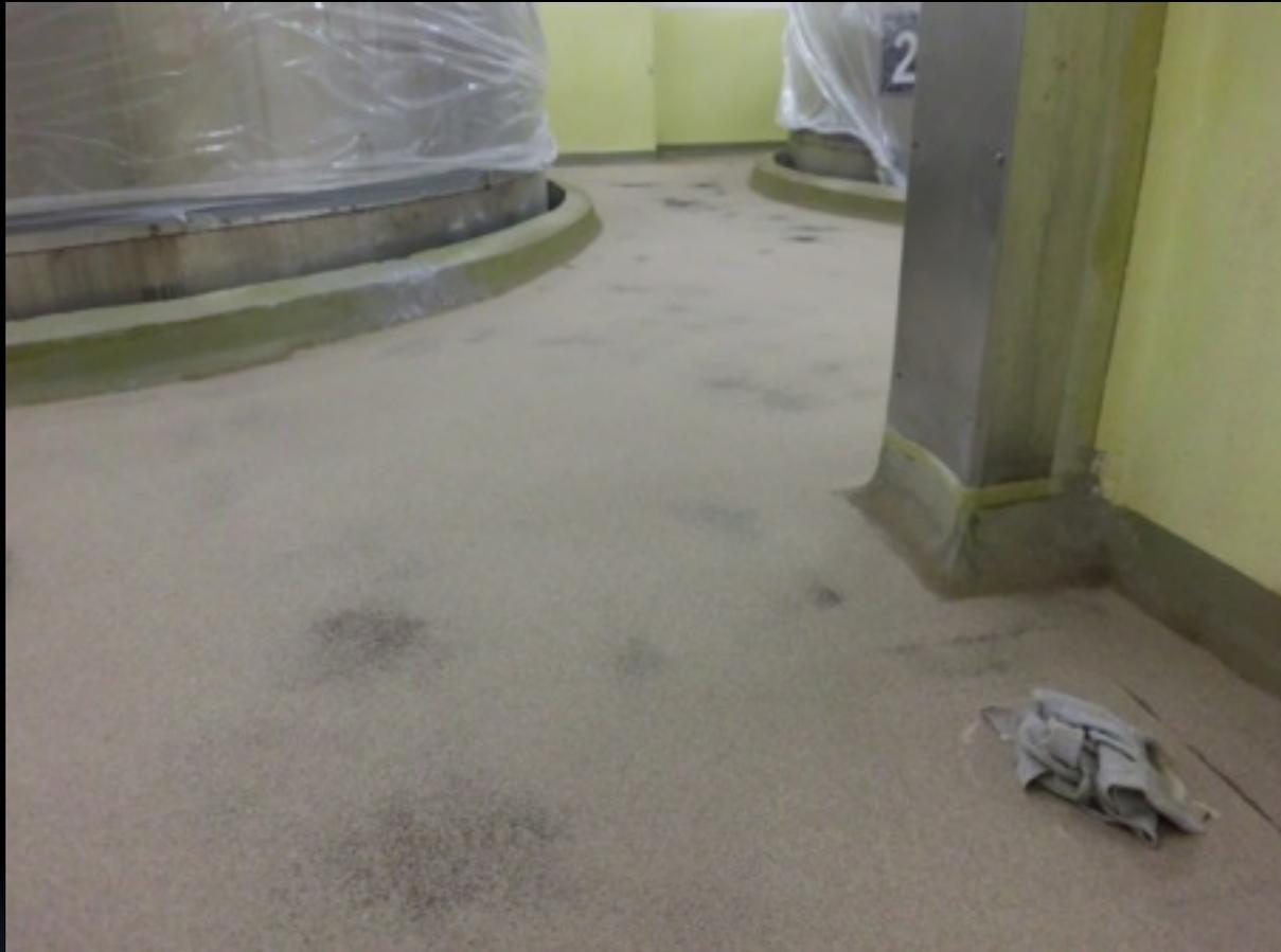
Aplicacion de Autonivelante Impermeable saturado de arena
