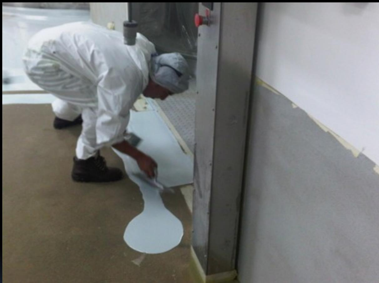
Aplicacion de Revestimiento en pisos saturado de arena
